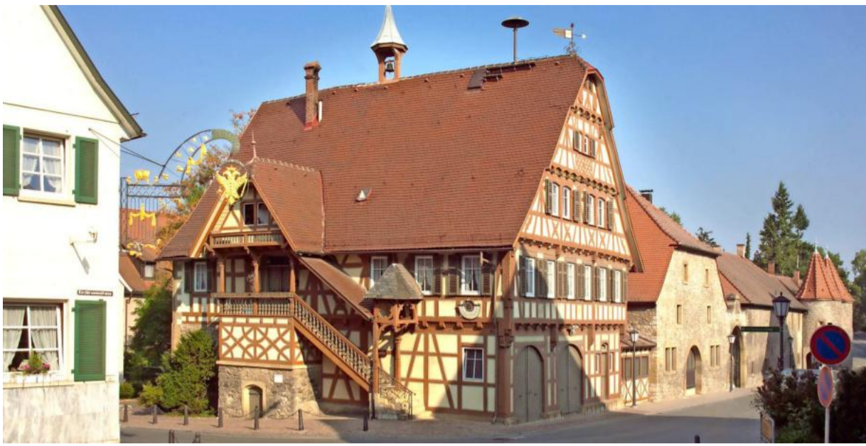
Ein Jahr sollen die Sanierungsarbeiten am Alten Rathaus in Kochendorf dauern. Das Obergeschoss soll weiterhin von Vereinen genutzt werden, der Ratssaal wird zum Vortragsraum. Foto: privat
