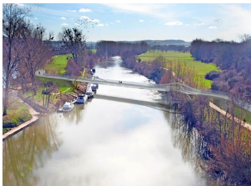
Eine der geplanten Radbrücken wird an der Nordspitze der Neckarinsel beim Jachthafen über den Altnecker führen. Visualisierung: Regierungspräsidium Stuttgart
