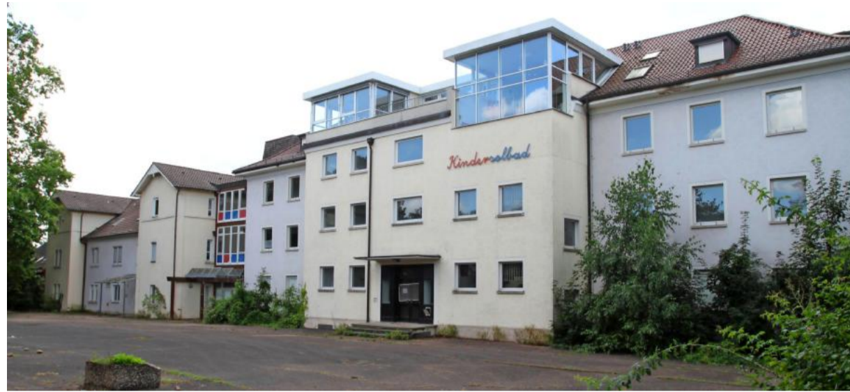
Das alte Kindersolbad hat Jagstfeld über Jahrzehnte geprägt. Weil es nicht wirtschaftlich saniert werden konnte, wurde es an einen Investor verkauft, der auf dem Gelände rund 100 neue Wohnungen plant.
